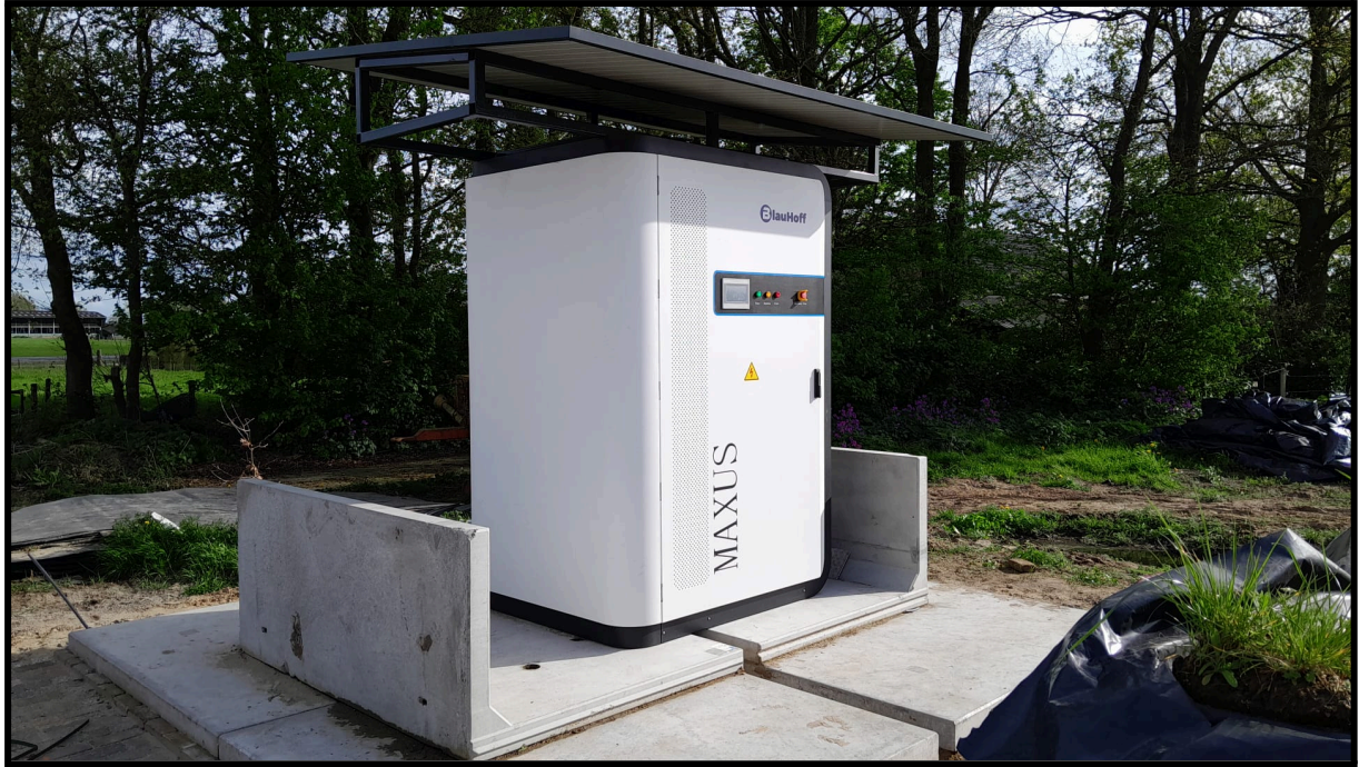
voorbeeld stootbuffer dmv keerwanden bescherming tegen botsen
