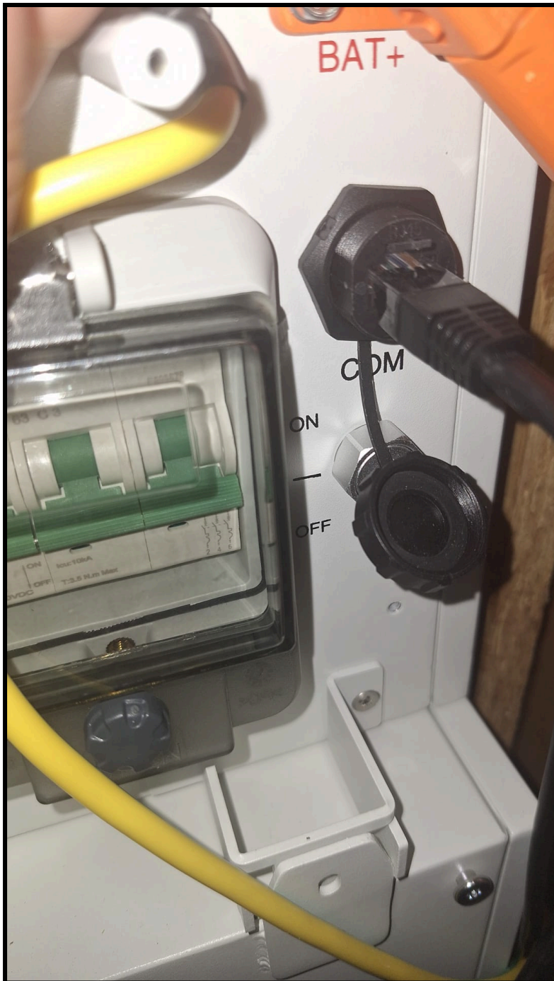
Plaats communicatiekabel in BMS poort omvormer.
