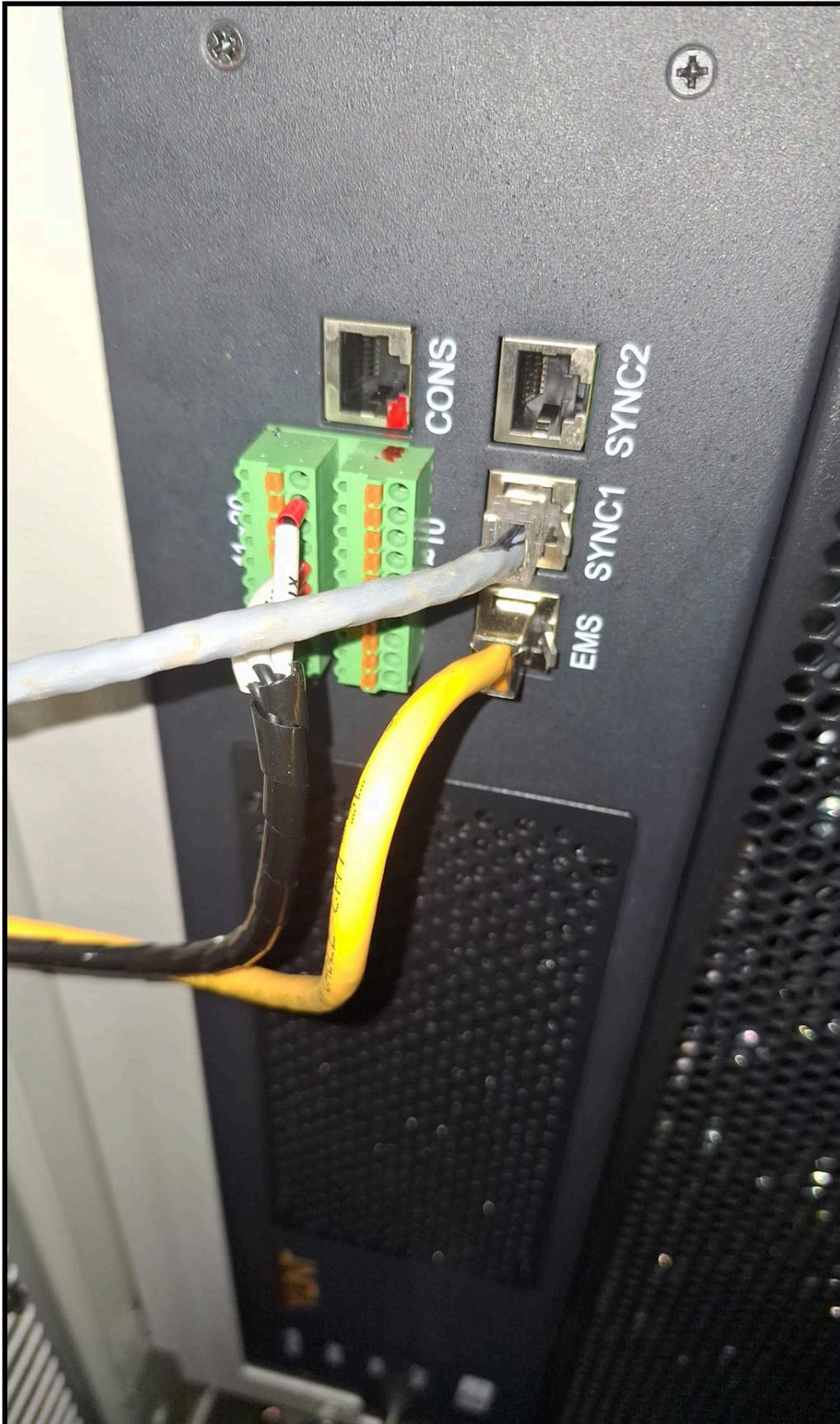
Unten links auf dem Maxus befindet sich das PCS. Am Port SYNC1 muss das Kommunikationskabel zum STS eingesteckt werden.
