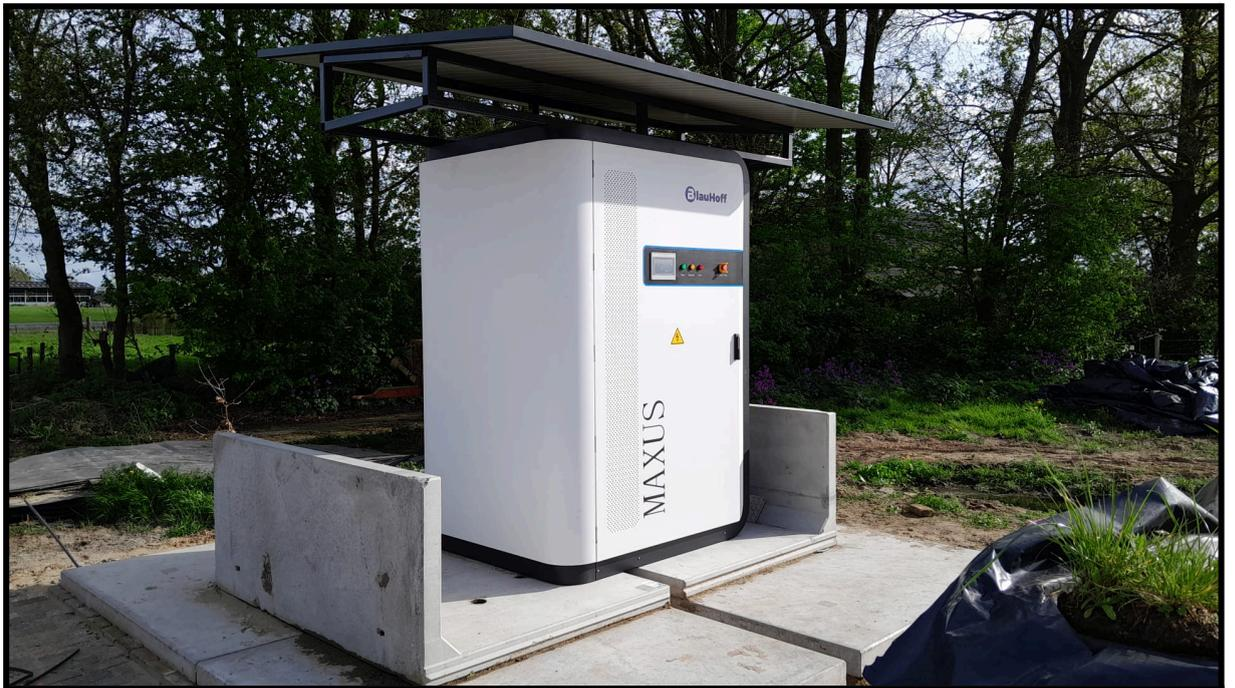
Beispiel eines Anprallpuffers mit Stützwänden zum Schutz vor Kollisionen
