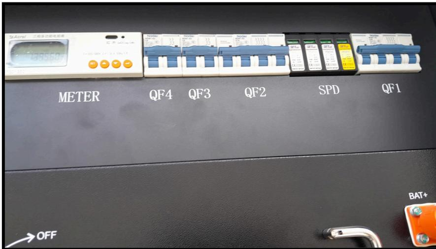
PDU de DC switch (großer Hebel)
